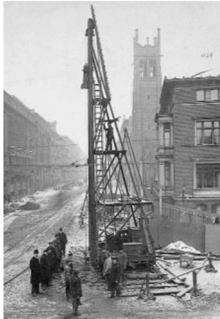
Anonym, U-Bahnbaustelle Nollendorfplatz und Amerikanische Kirche in der Motzstraße, 1910. Kollodiumpapier, 28,5 x 19,7 cm. Aus dem Konvolut: U-Bahn-Bau in Schöneberg, Museen Tempelhof-Schöneberg
